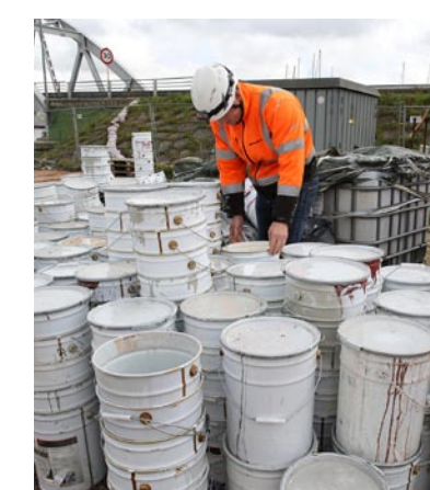
Så meget maling går der til et buefag på broen.
